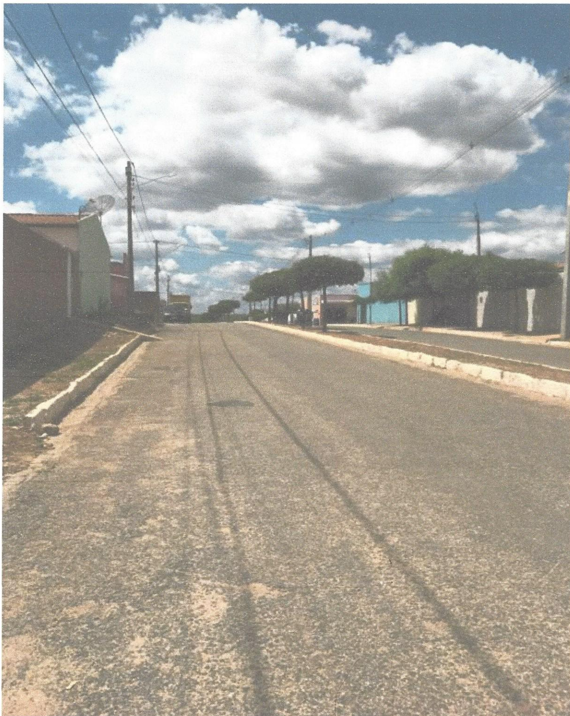
Fotografia 01 – Rua Brasilino de Brito
