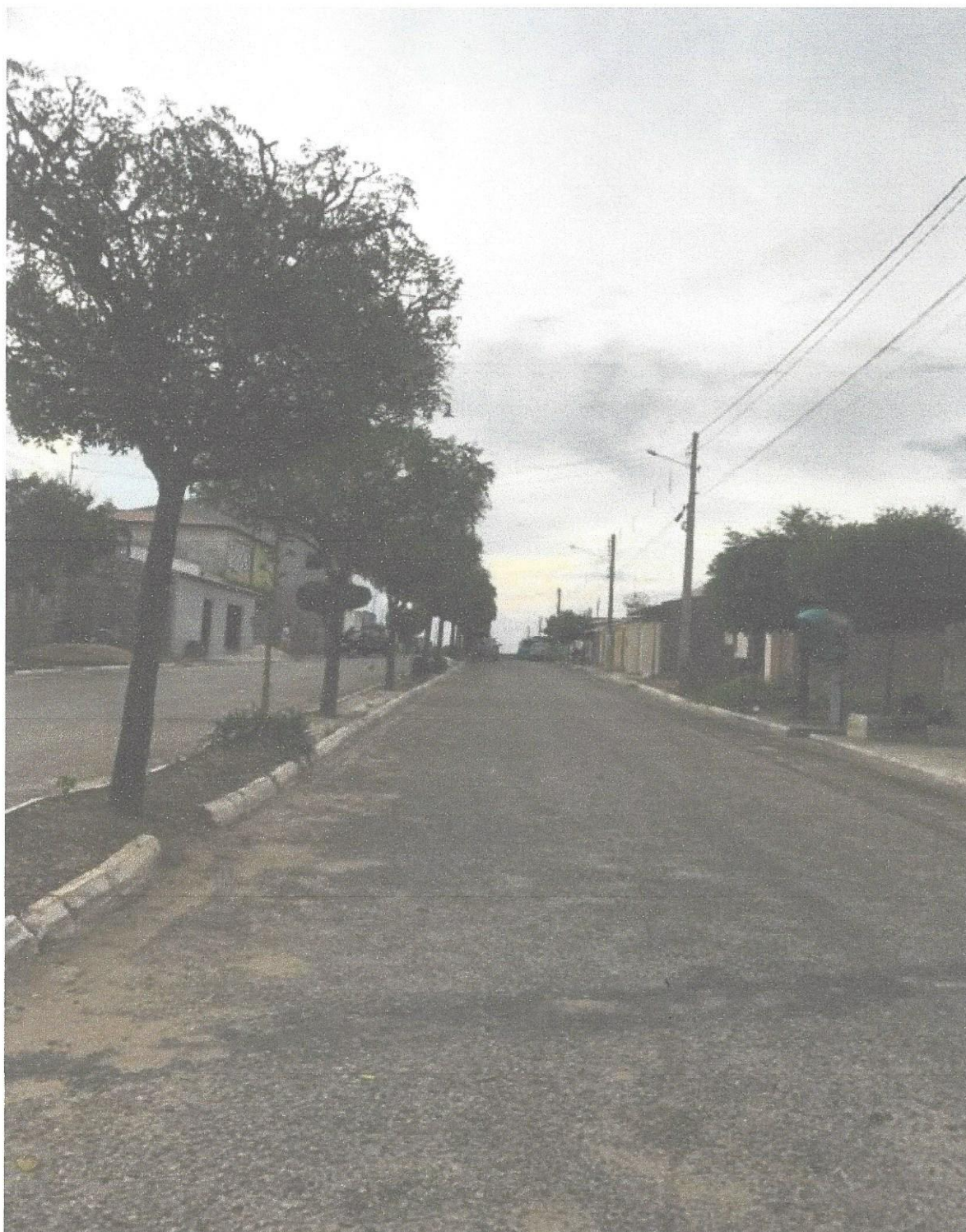
Fotografia 03 – Rua Brasilino de Brito
